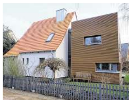
Eine durchgehende Glasfuge trennt den Anbau vom alten Haus ab
