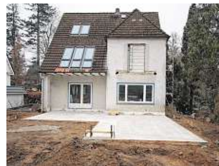
Die Bodenplatte zeigt, wie der Altbau in Blankenese erweitert werden soll
